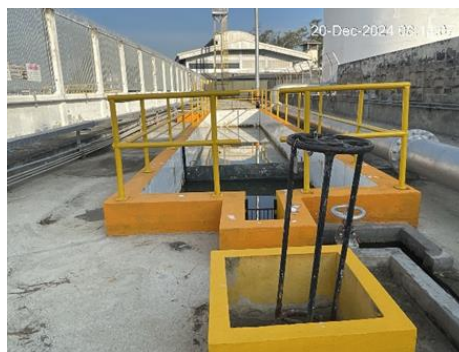
ภาพที่ 9 บ่อดักครบน้ำมัน Oil interceptor เพื่อทำการแยกน้ำมันออกจากน้ำก่อนระบายสู่สาธารณะ
